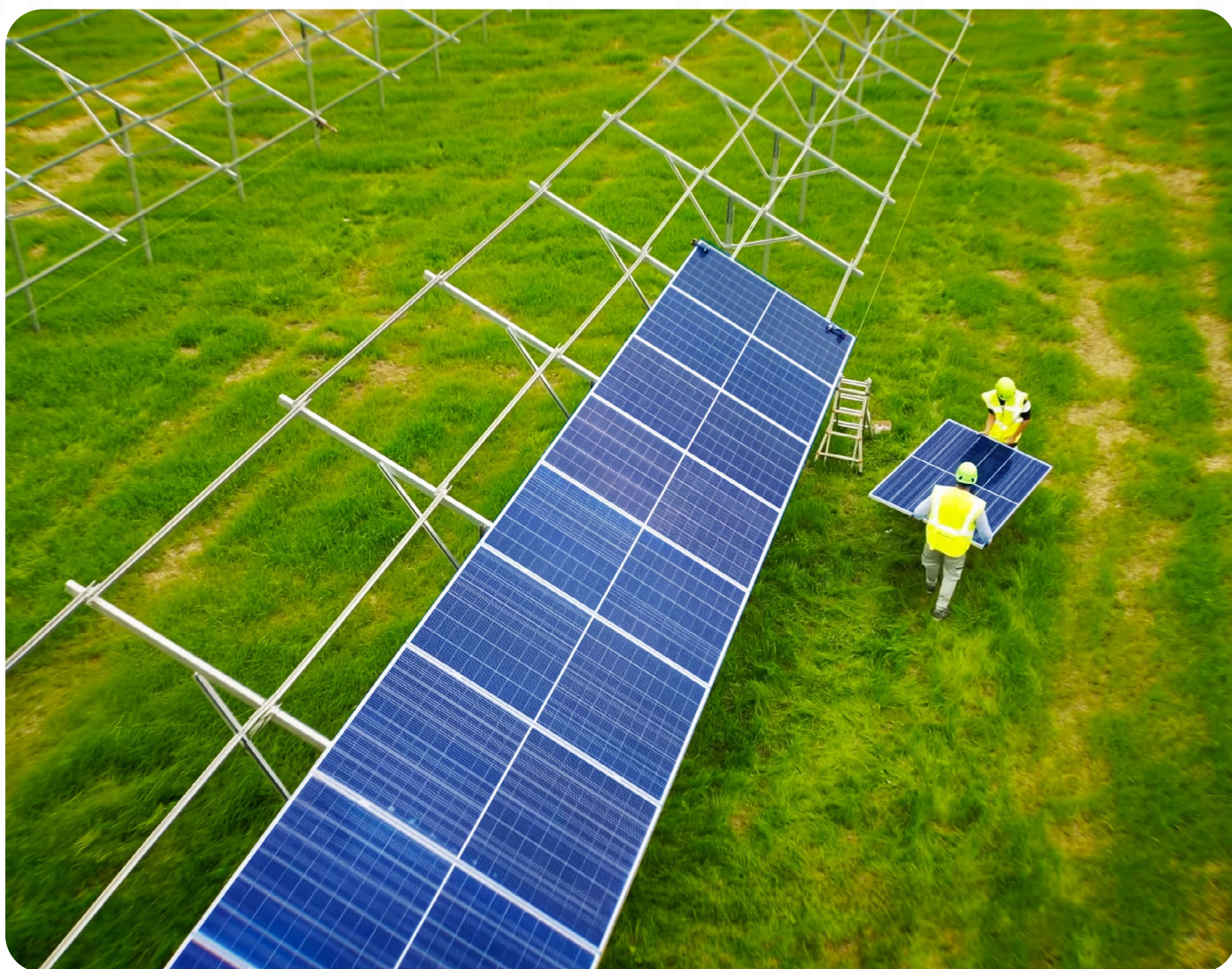
Installazione impianto presso Finissaggio & Tintoria Ferraris S.p.A.
